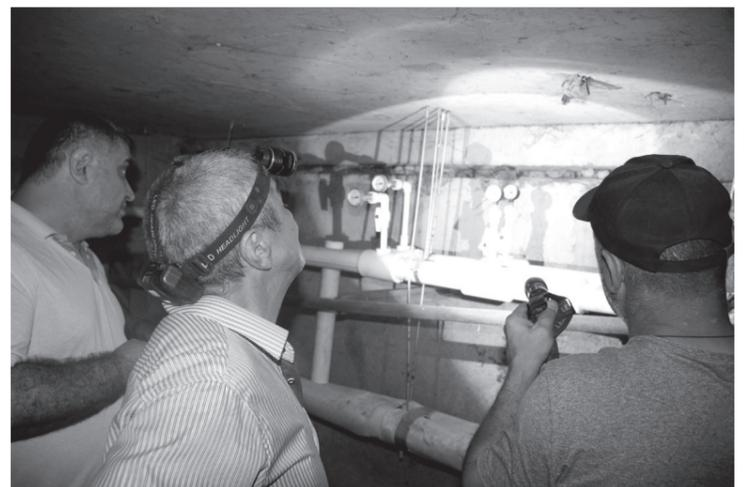
Гидравлическая опрессовка систем отопления в многоквартирных домах (МКД) в Буйнакске, как и везде, проводится для проверки герметичности системы перед началом отопительного сезона. Процесс включает в себя заполнение системы водой, создание повышенного давления и его выдержку для выявления утечек.
